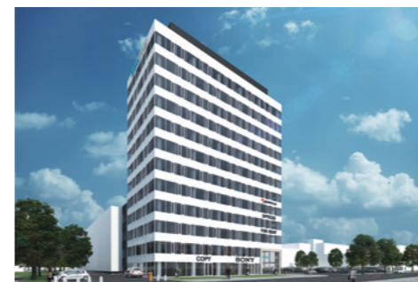
Kanceláře, 23 – 455 m 2 , Brno, Královo Pole
